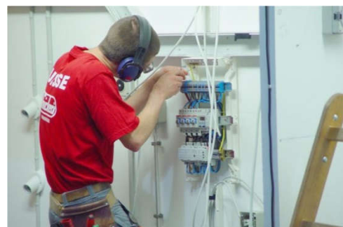
Gambar 4.2. Pemasangan Panel
