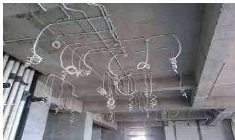
Gambar 4.1. Pemasangan instalasi listrik
